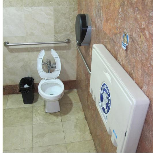
Imagen: Sanitario accesible (barras de apoyo y accesorios al alcance de personas en silla de ruedas, así como área de transferencia).
