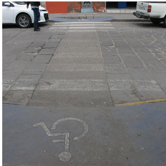
Imagen: Rampas alineadas y cambio de textura en paso (sobre arroyo vehicular).
