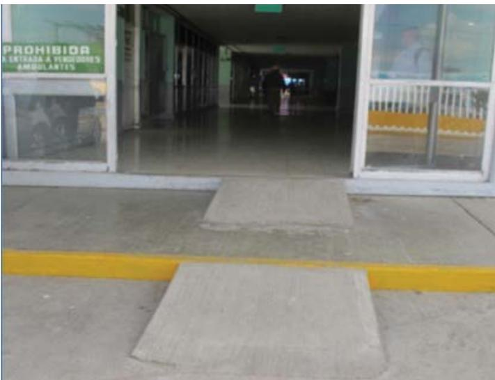
Imagen: Rampa para persona usuaria de silla de ruedas que cumple con el ancho mínimo; es funcional para su uso, es accesible.
